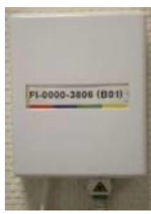
Figure 8 : FTTE passif NRO - exemple de PTO
